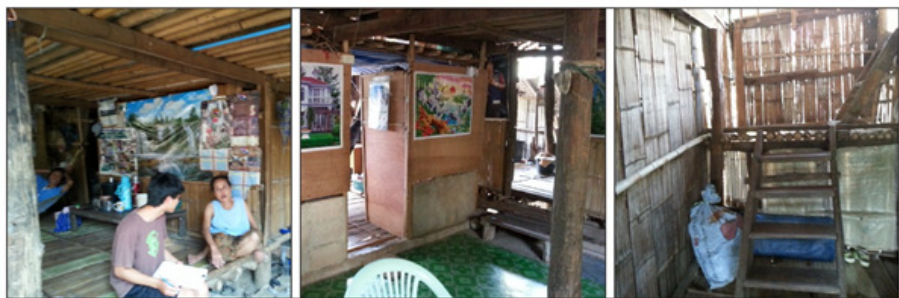
พื้นที่ชั้นที่ 1 ที่เปลี่ยนเป็นห้องนอน/เก็บ และนั่งพักผ่อน พื้นที่โถงรับแขกชั้นที่ 1 เพื่อแจกจ่ายไปยังส่วนต่างๆ บันไดที่ปรับปรุงให้อยู่ในบ้าน
